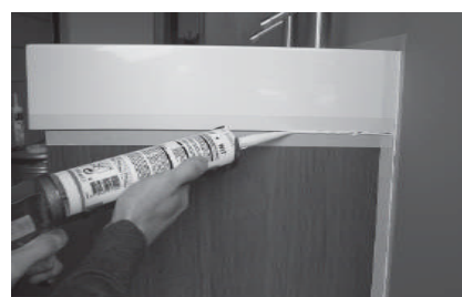
3. Afkitten tussen onderkast en wand; en tussen wastafel en wand
