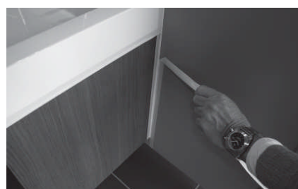
4. Schilderstape direct na gladstrijken verwijderen en de kitnaad nog 1 maal nastrijken
